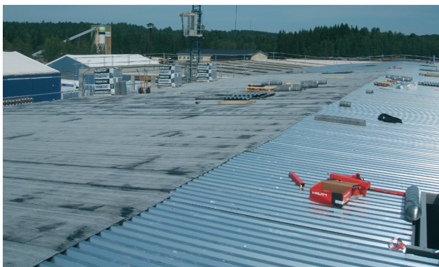
Direkt på plåten ligger en diffspärr på 2,5 mm.
