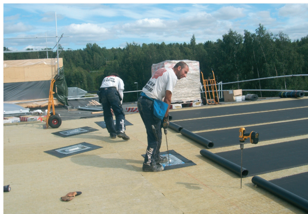
På isoleringen läggs Derbigum SP 4 mm. Ett tak med maximal trygghet och ekonomi.
